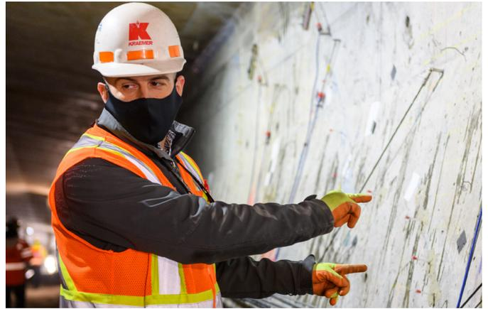
Para saber más sobre cómo responde el puente a diferentes condiciones, las cuadrillas han estado usando un sistema de monitoreo inteligente en una sección del puente con grietas. **Imagen cortesía de:** Tim Durkan
